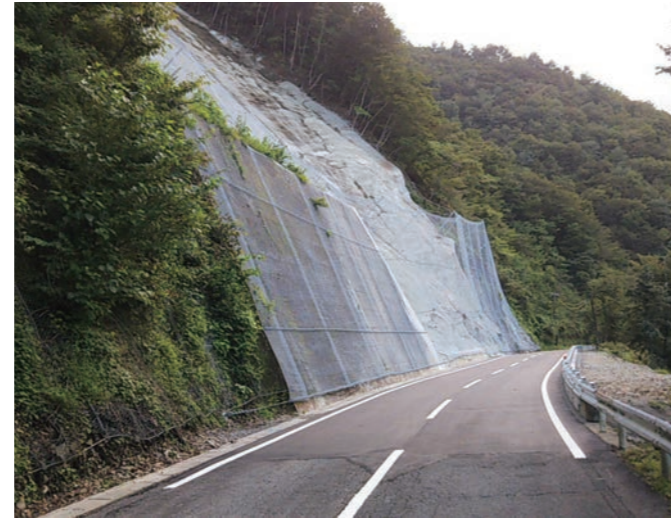
工事名：公共防災・安全交付金(災害防除) 【翌償】(主)金山明宝線 発注者：岐阜県下呂土木事務所
