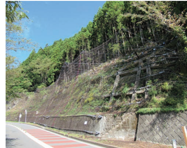
工事名：道路災害防除工事(2奥の6) 発注者：東京都西多摩建設事務所
