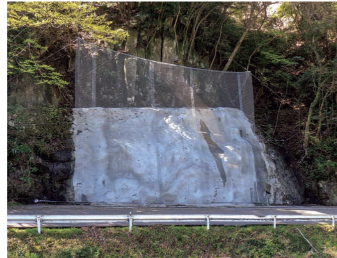
工事名：令和3年度 市道木落線落石対策工事 発注者：豊後大野市(大分県)
