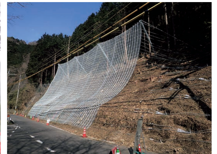
工事名：管内一円(和束井手線) 平成30年発生土木災害復旧工事 発注者：京都府山城北土木事務所
