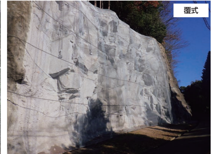
工事名：R2農保対大野川上流地区法面改修工事 発注者：竹田市(大分県)
