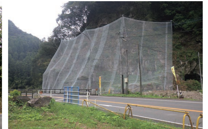
高エネルギー吸収型ポケット式落石防護網 (支柱間隔が広い)
