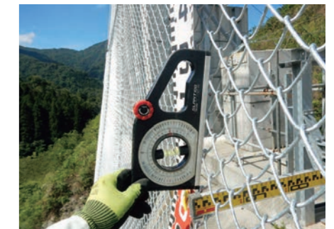
阻止面設置角度確認
