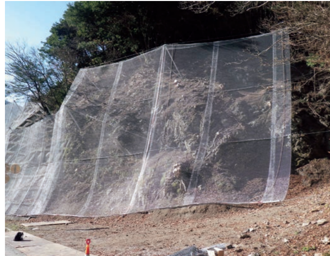
工事名：国道306号 補助道路修繕工事 発注者：滋賀県湖東土木事務所
