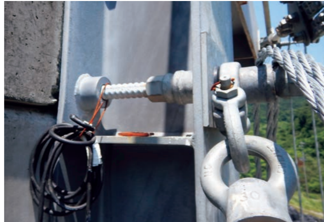
左写真の実験終了後アンカー部 (変形・破損等は無し)
