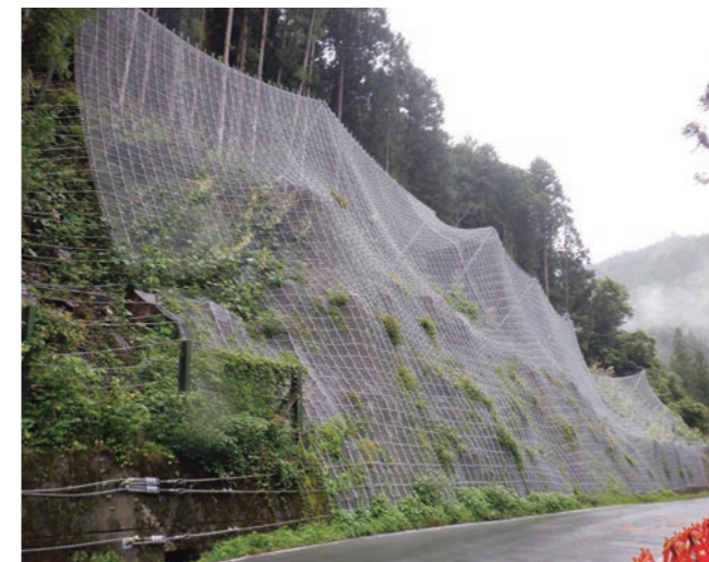
工事名：令和元年度(債務)道路防災国交付金事業 (防災・安全交)(国)152号道路防災工事(大井A040) 発注者：浜松市天竜土木整備事務所
