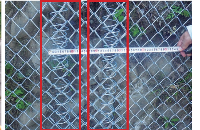
金網重ね部の結合コイル配置 (ネットタイプ共通)
