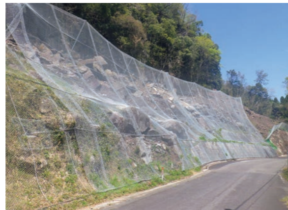
KB-NH4.0-1型 施工事例（2スパン）
