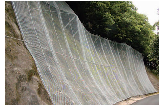
従来型ポケット式落石防護網 (支柱間隔が狭い)
