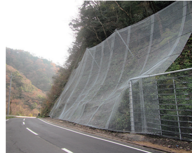
工事名：(一)佐田八神線 大呂工区道路災害関連 (災害対策推進)工事その1 発注者：島根県出雲県土整備事務所
